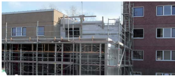
Rohbau neuer Mittelteil
