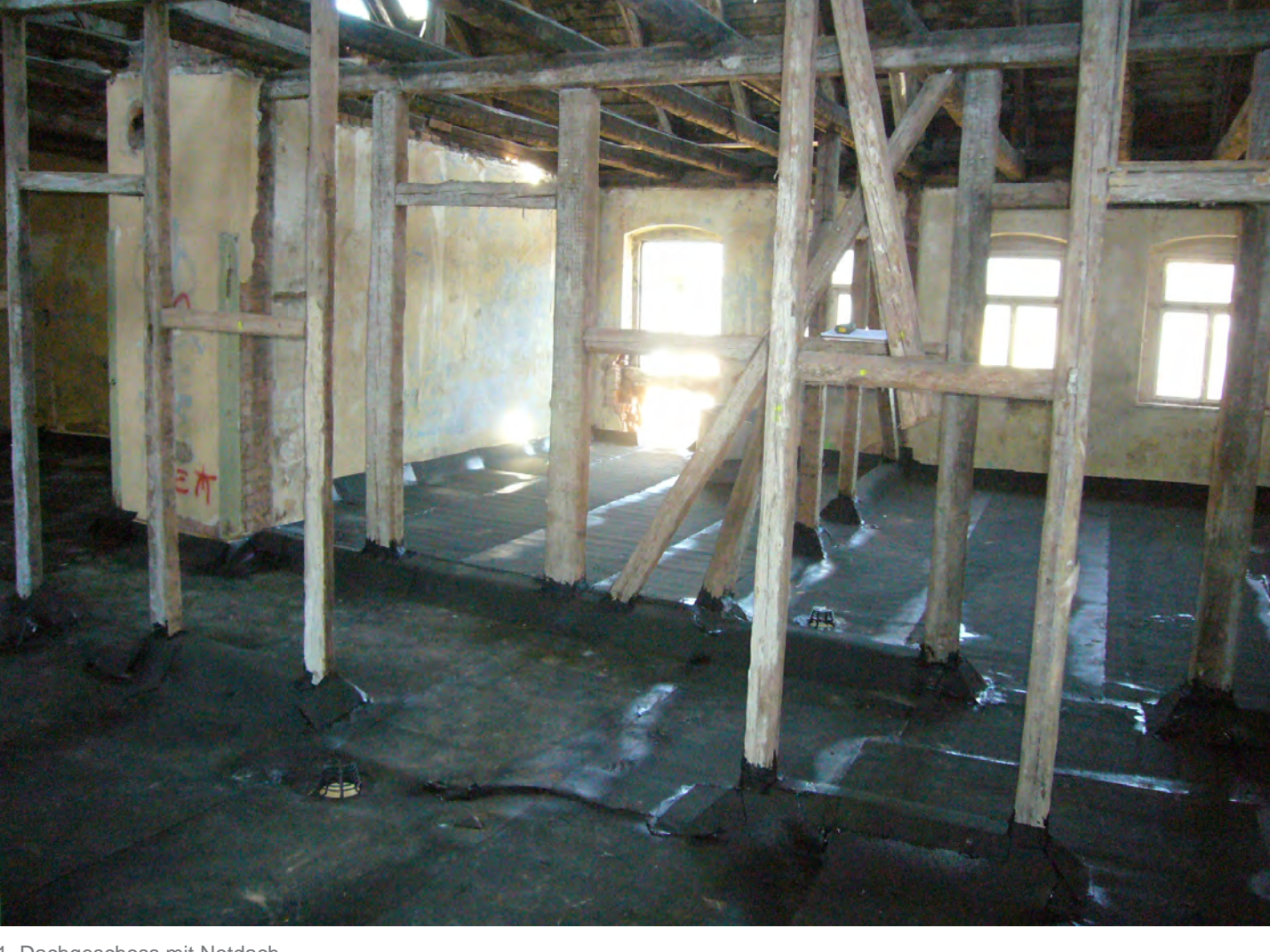
1. Dachgeschoss mit Notdach
